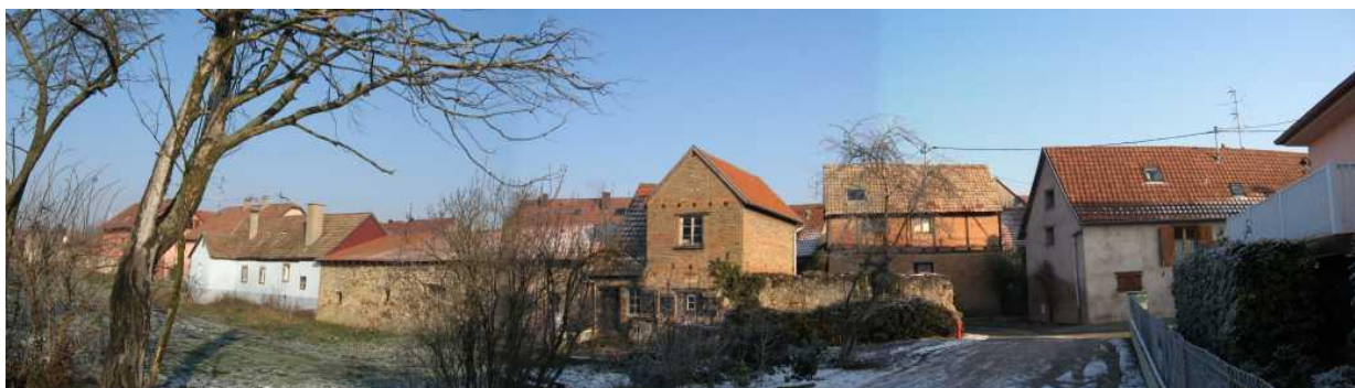
Constructions de limite séparative latérale à limite séparative latérale à l'ouest du village, le long du fossé. L'ensemble forme un front bâti très homogène.
