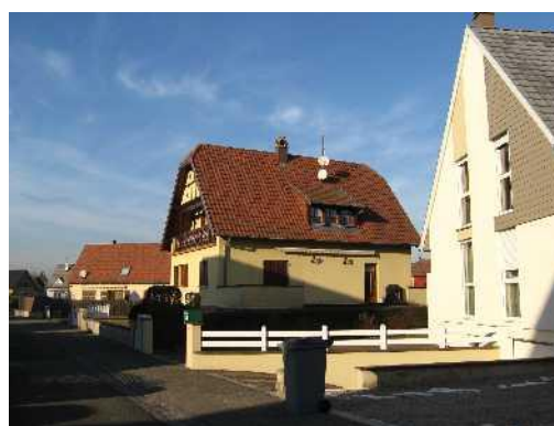
Rue Max de Reinach : R + C + rampe d'accès au garage
