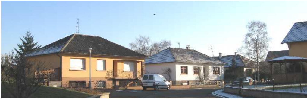
Rue Herrade de Landsberg : Un rez-de-chaussée surélevé par rapport à la voie pour permettre une rampe de garage
