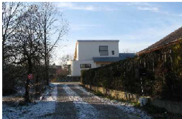
Toiture arrondie – Rue Herrade de Landsberg
