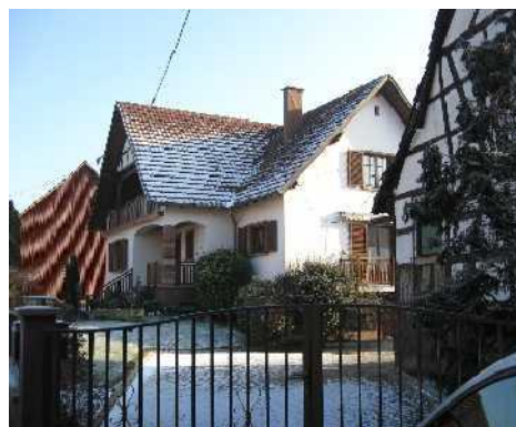
Pavillon Rue Basse (hangar métallique à l'arrière plan)
