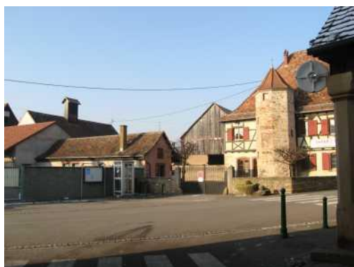
Mairie avec espace de stationnement
