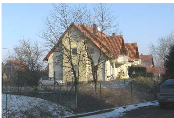
Rue Basse : R + C. A noter, le remblaiement du terrain (proximité de l'Ehn)
