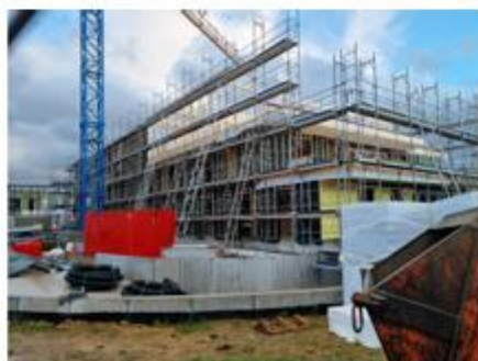
Chantier du pôle administratif et technique de la communauté de communes du Pays de Sainte-Odile, au quartier des Roselières, pendant la construction, phase gros œuvre. Photo G. M.
