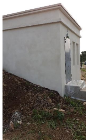
réservoir du Kils
