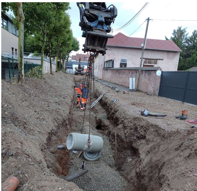
Travaux de renforcement du réseau d'assainissement rue Abbé Osterlé à Obernai
