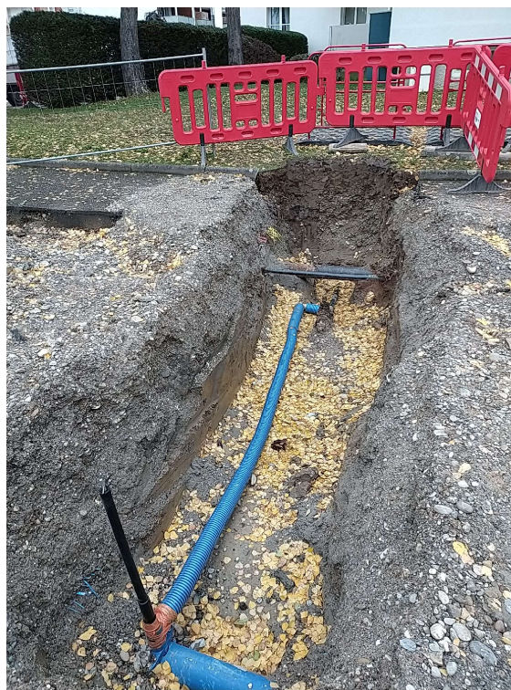
Pose de conduite fonte et renouvellement de branchement rue des Champs Verts
