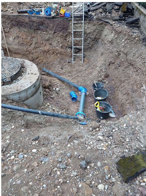
Raccordement conduite rue du Côteau
