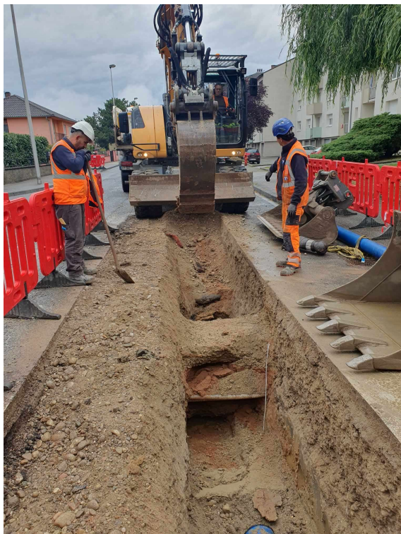
Pose de conduite fonte et renouvellement de branchement rue des Champs Verts
