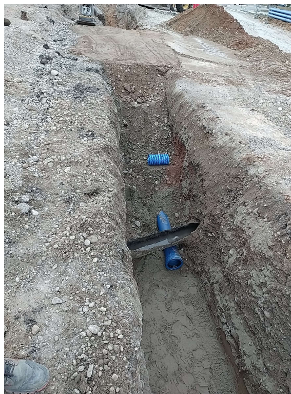
Pose canalisation 150 mm rue Albert Osterlé
