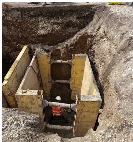
Renouvellement des branchements de 2m00 à 4m50 de profondeur
