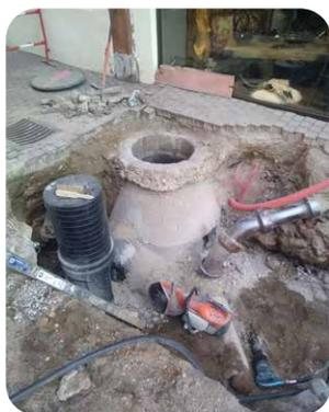
Renforcement du réseau d'assainissement unitaire rue du Marché à Obernai par la pose de 30ml de tuyau en PE annelé DN500mm
