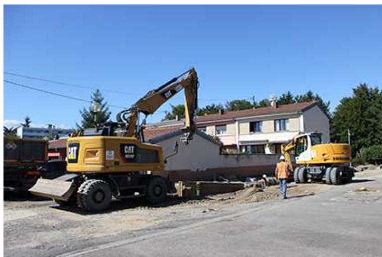
Travaux de la place des 27 à Obernai (09/2019)
