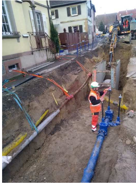
Travaux de traversée de Krautergersheim (09/2019)
