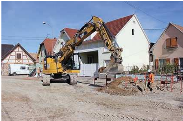
Travaux de la route de Strasbourg à Meistratzheim (10/2019)
