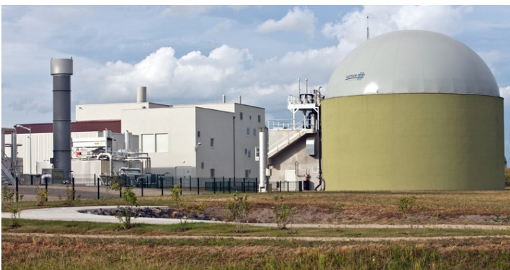
Station d'épuration de Meistratzheim
